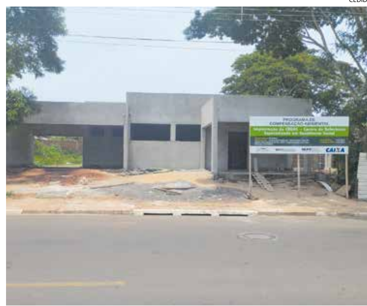
Obra em andamento do Creas
